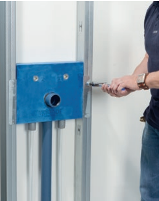
Atbilstoši noteiktajam iebūvēšanas augstumam stiprinājuma plāksne tiek gofrējot savienota ar profiliem – gatavs!
