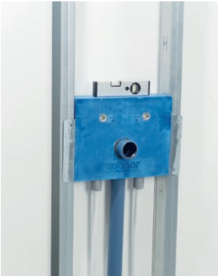
Uponor Smart ISI kaste tiek ievietota horizontāli starp iepriekš uzstādītiem sausās būves profiliem.
