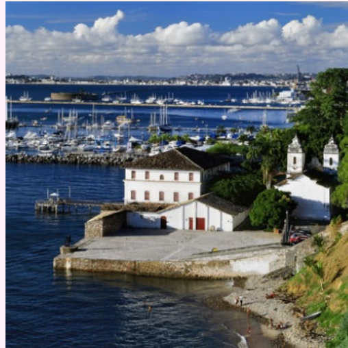
Sklavenhaus und Kapelle in Unhão, Salvador, Bahia
